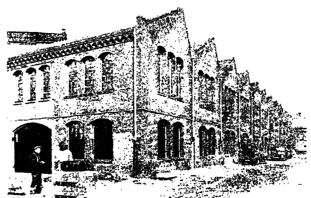
Die Shed-Hallen der ehemals Arnheimschen Kassen- und Tresorfabrik an der Panke
